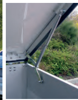
Deckelschere mit Gasfeder.
